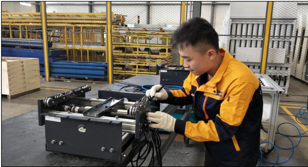
图 安装调试顶升移栽机
